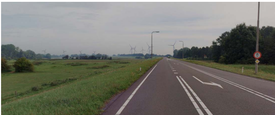
Figuur 3.3 - In het verlengde van de weg een voorbeeld van een gezichtspunt van waaruit een geknikte of gebogen lijnopstelling als rommelig kan worden ervaren. Links ook een gebogen opstelling, maar hier gezien van verderaf en meer haaks op de lijn, waardoor het beeld van deze opstelling wel rustig is.
