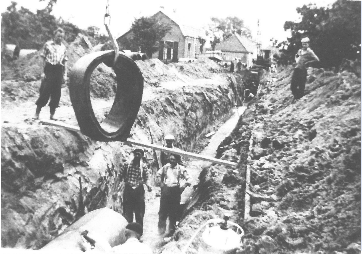
Aanleg riolering Kornet van Limburg Stirumstraat (Olst 1960)
