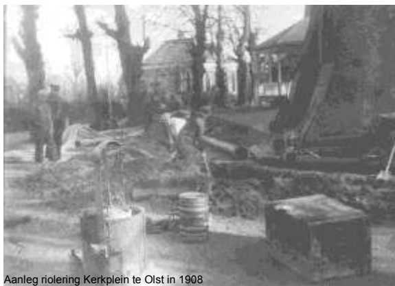
Aanleg riolering Kerkplein te Olst in 1908
