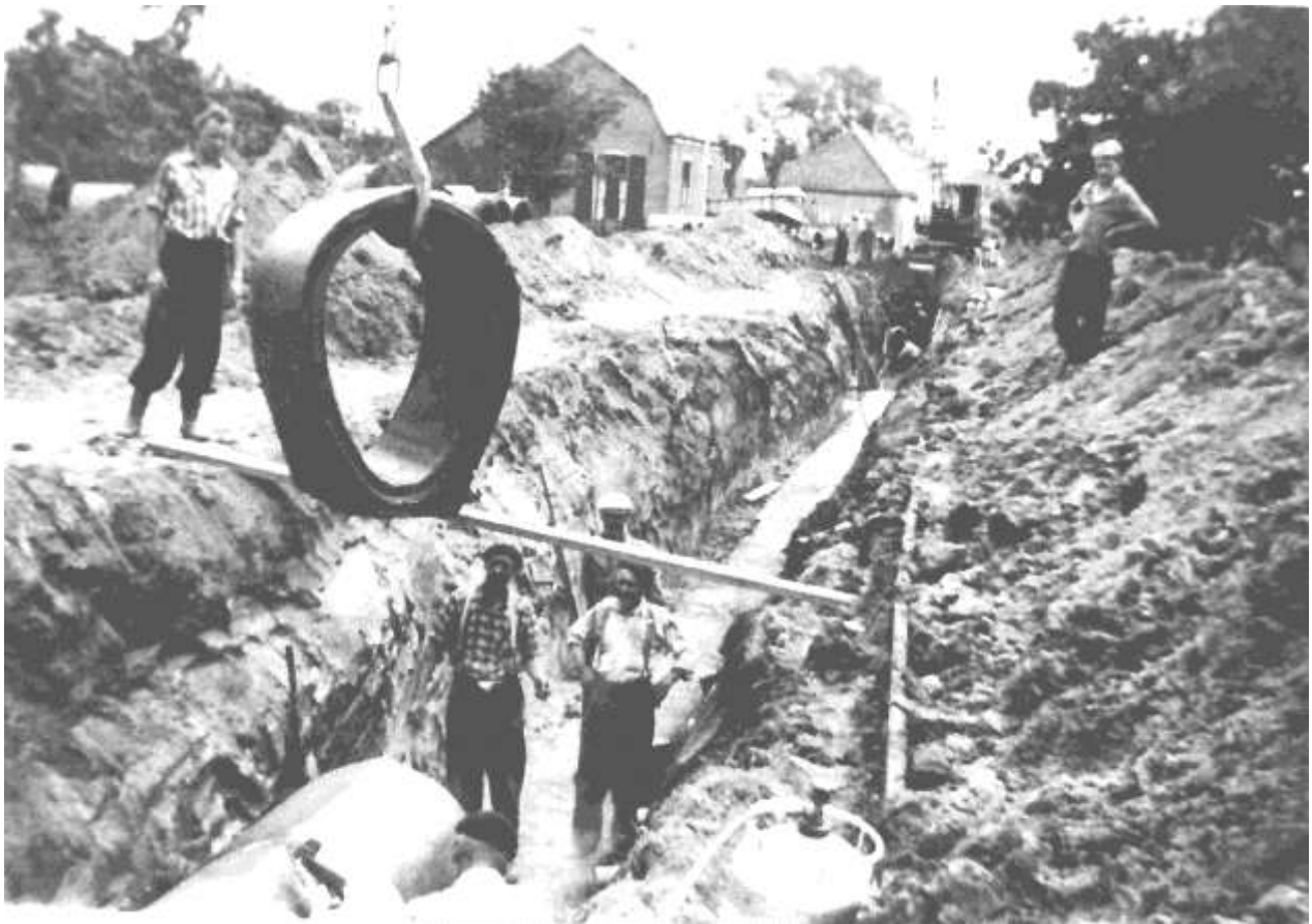
Aanleg riolering Kornet van Limburg Stirumstraat (Olst 1960)
