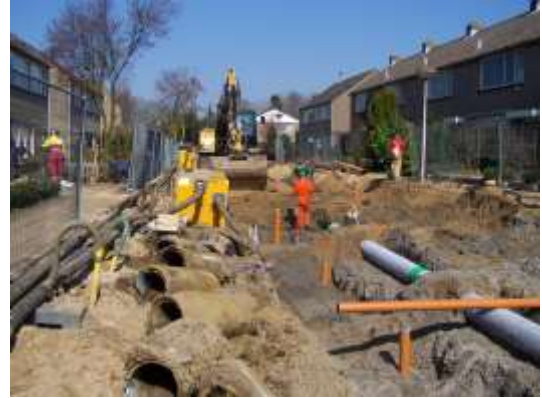
Aanleg gescheiden riolering (met IT-riool) Sichemstraat te Wesepe
