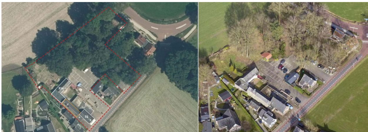
Figuur 1: overzicht begrenzing plangebied (links) en een luchtfoto van de bestaande situatie (rechts)
