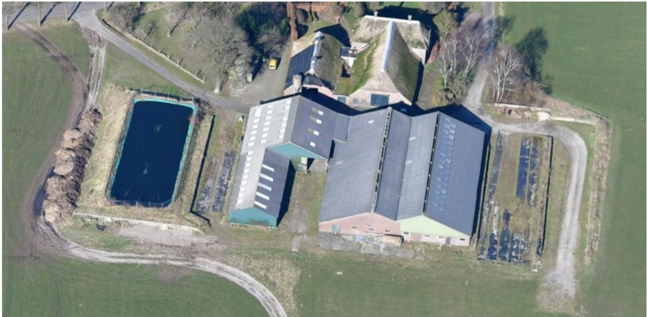
Figuur 1: luchtfoto uit 2018 van het erf aan de Steunenbergerweg 6
