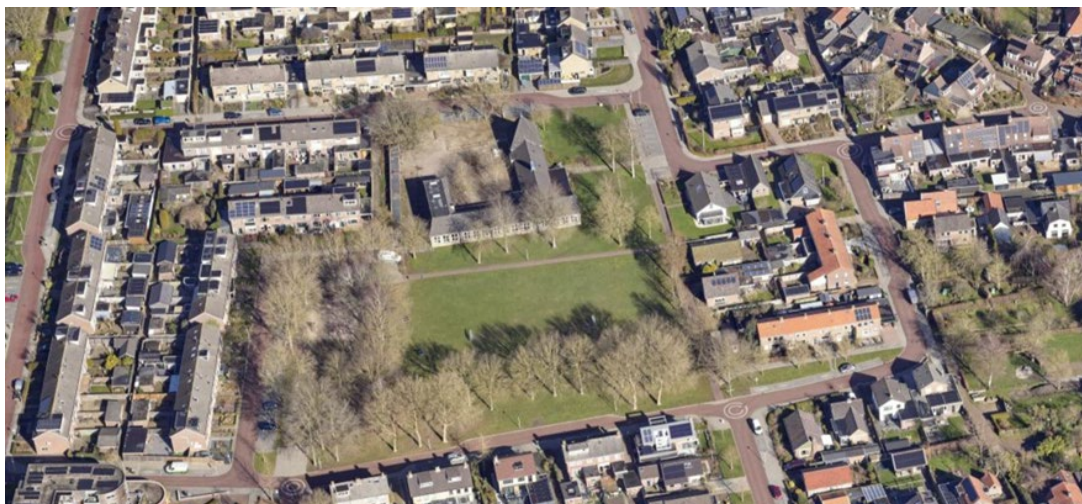
Figuur 2: Tellegenlocatie in bestaande situatie gekeken in noordelijke richting (luchtfoto dd. 15 maart 2023)
